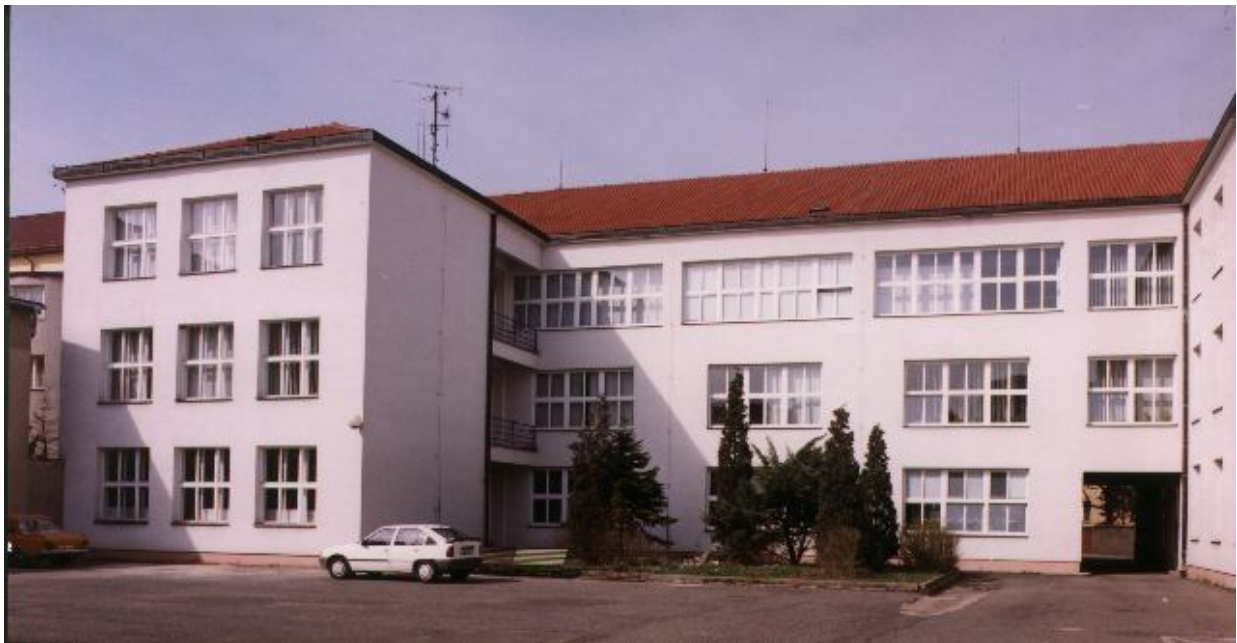
Budova školy SOŠT a SOU Louňy
