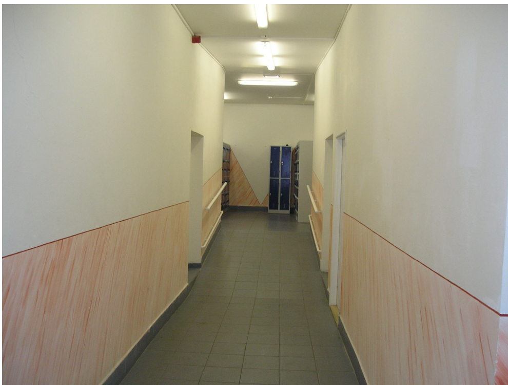
Šatny po rekonstrukci
