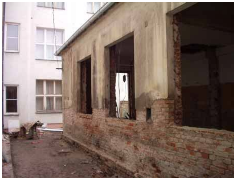
Bývalé prostory – dílny údržbáře, skladů a truhlárny
